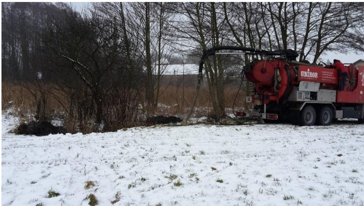
Spülung einer verstopften Verrohrung in Sembten
