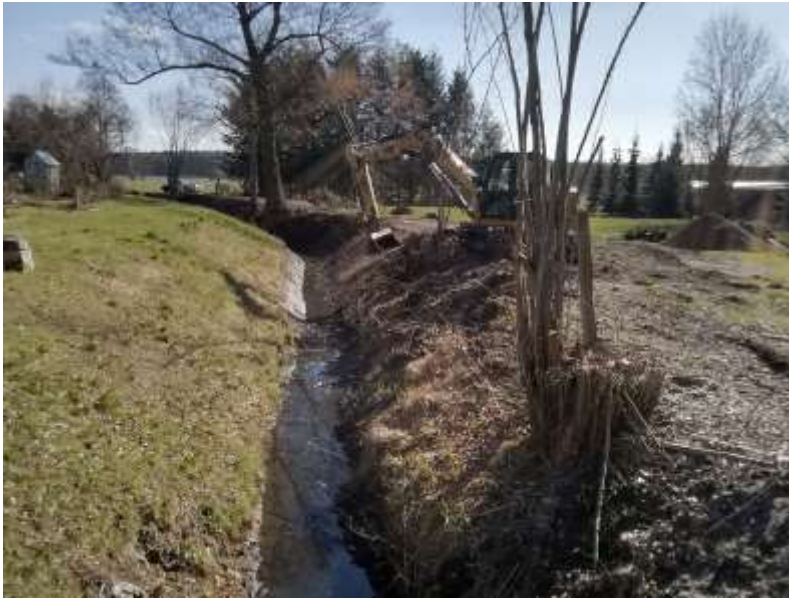
Räumung/ Reprofilierung des Ablaufgrabens in der Ortslage Wilschwitz
