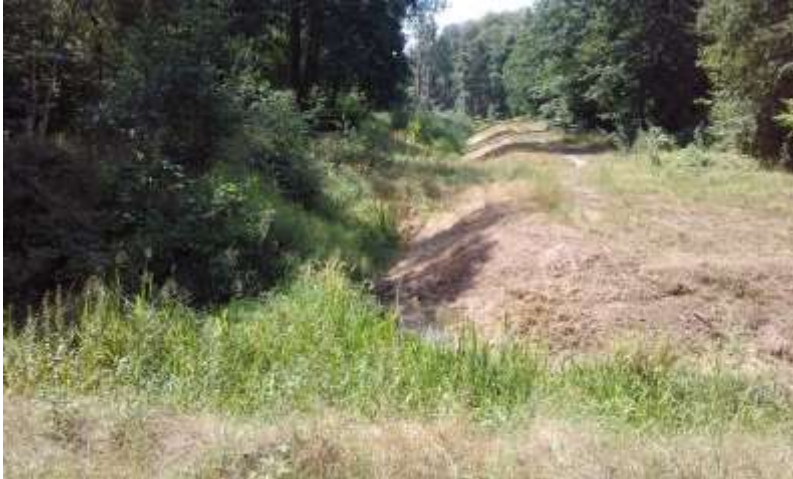
Malxe uh. Forst, aufgrund der Trockenheit wurde nur eine einseitige Böschungsmahd ausgeführt
