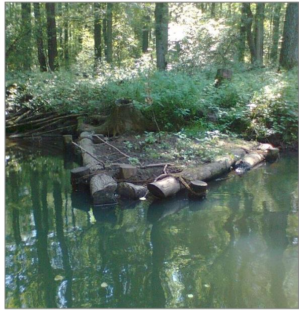
Abbildung 8.12: Wurzelstammbuhne (Spreewald)    Abbildung 8.13: Dreiecksbuhne (Spreewald)
